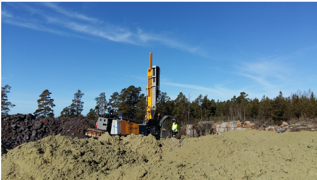
Kuva 3.2 Uusien kaasuntarkkailuputkien asentaminen jätetäyttöön 2017
